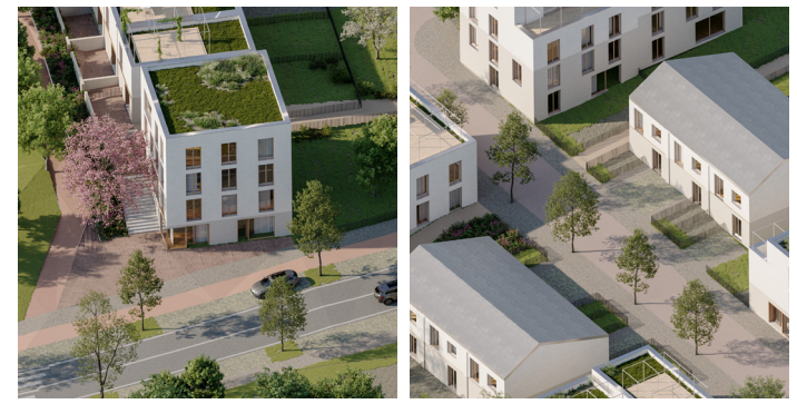
Vstupní bod do území směrem od centra tvoří polyfunkční dům s aktivním parterem a pobytovým předprostorem.
